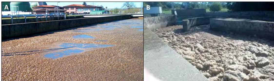
Figura 5 A) Imagen de bulking en una planta de tratamiento de aguas residuales. B) Imagen de foaming en una planta de tratamiento de aguas residuales.
